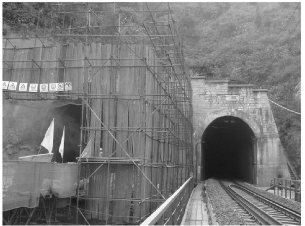
图 1 新刘家沟隧道与既有隧道洞口照片
